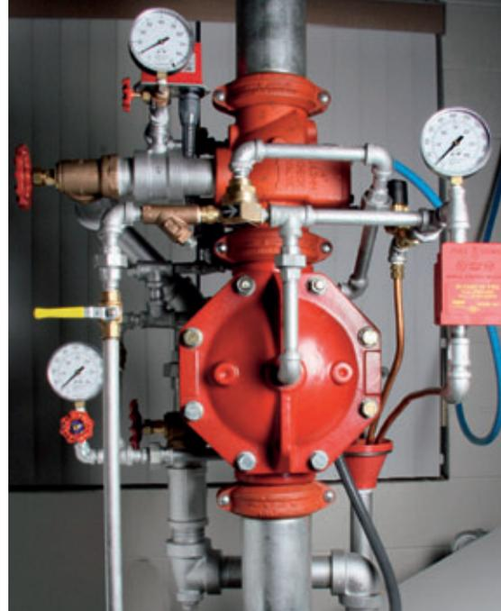
Клапан DV-5 системы предварительного действия
